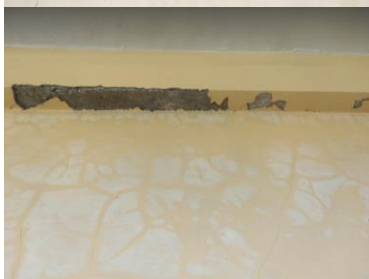
Spalling
