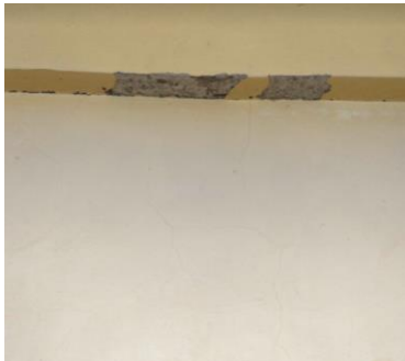
Spalling
