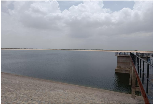
Fig-1 Malsisar dam
